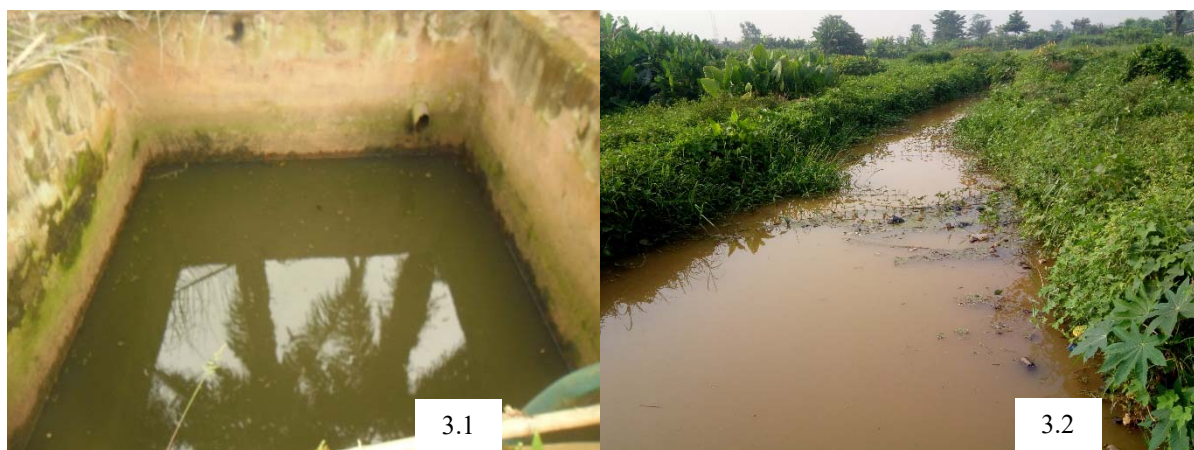
Planche 2 : Ouvrage d'accès à l'eau et bassin de retenue d'eau à Porto-Novo (Founfoun Tokpa)
